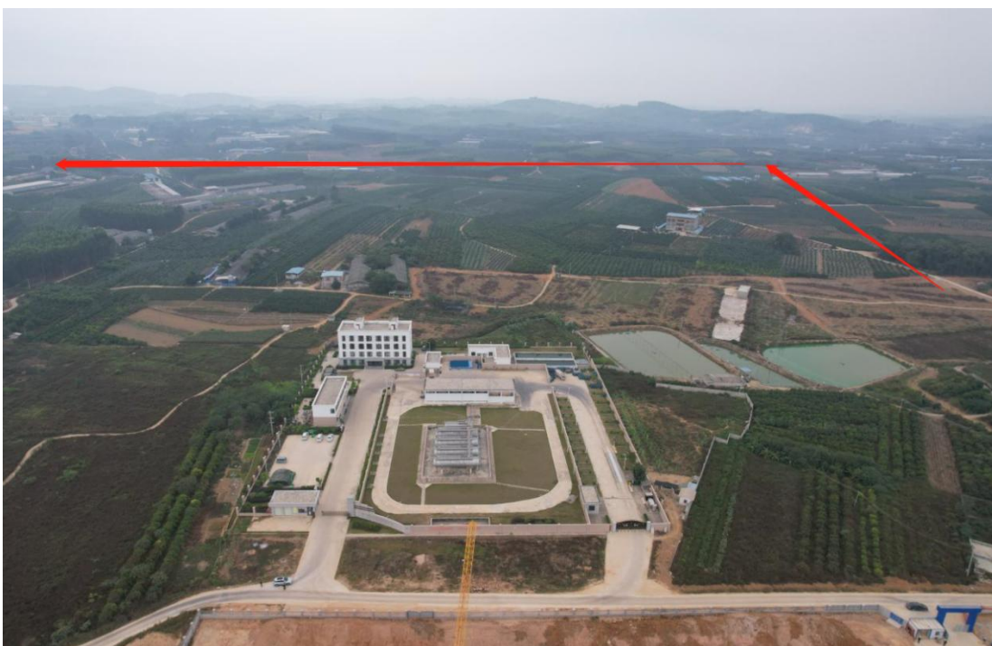
图 2 线路工程出线方向
