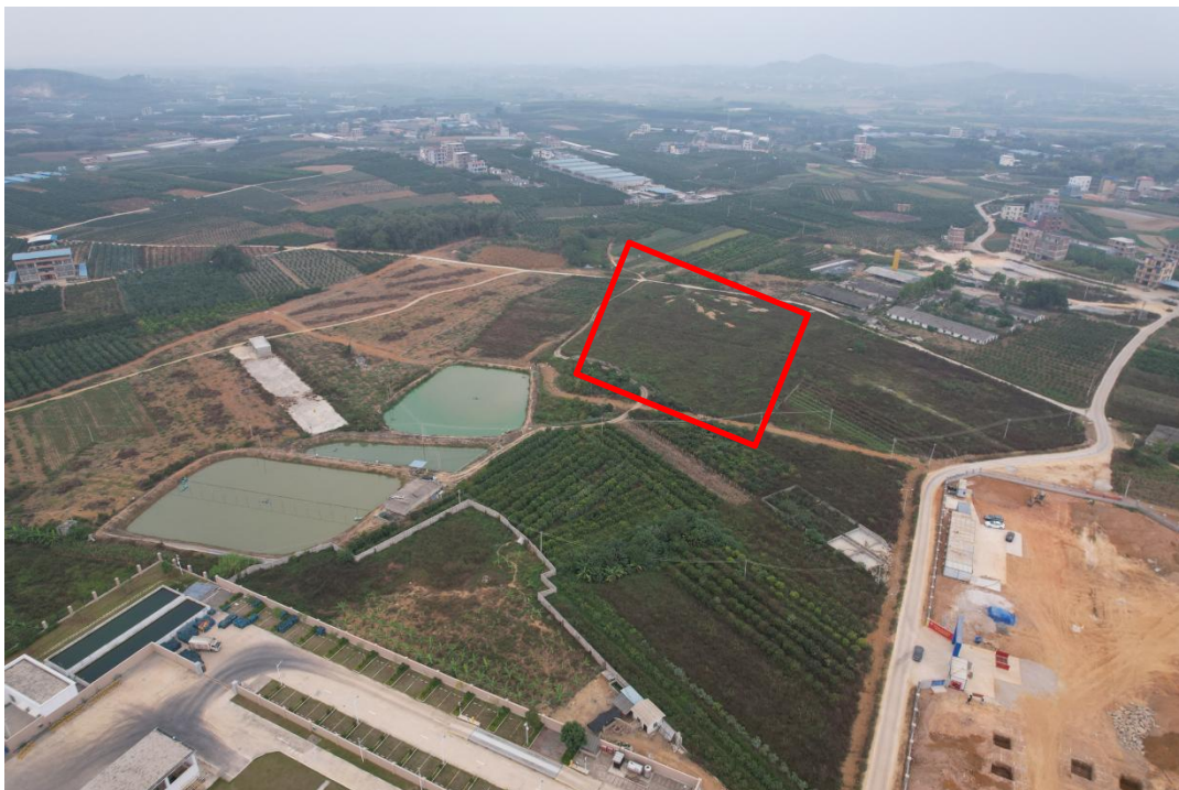
图 1 储能站建设区
