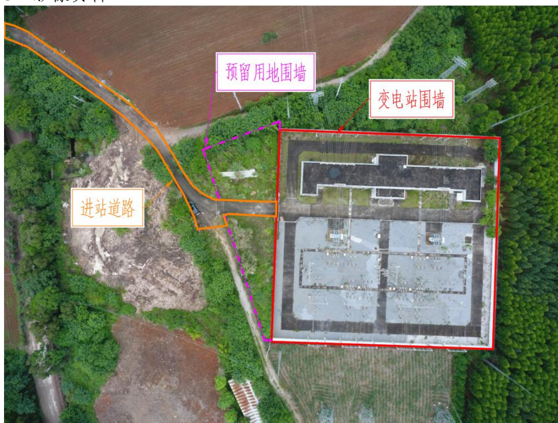
35kV 城东变电站现状
