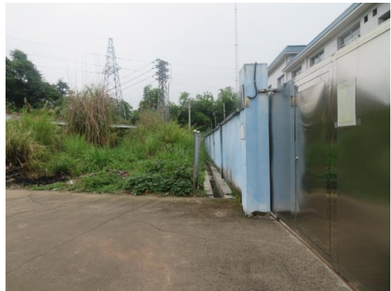
站外排水沟、绿化
