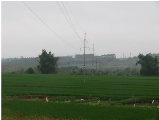
35kV 南桥连线 6~10 号
