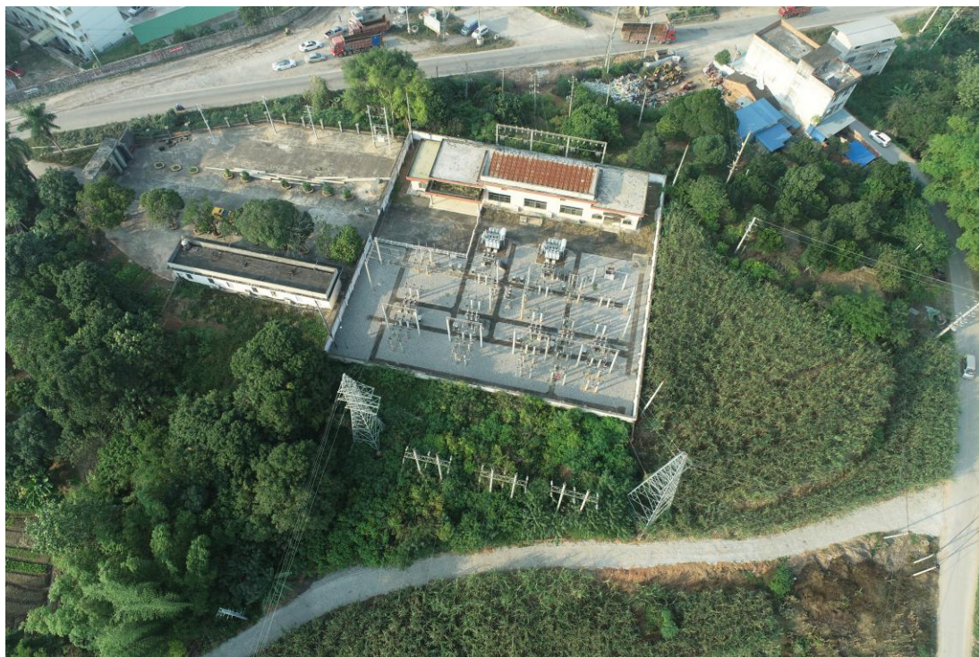
35kV 那堪变电站出线现状
