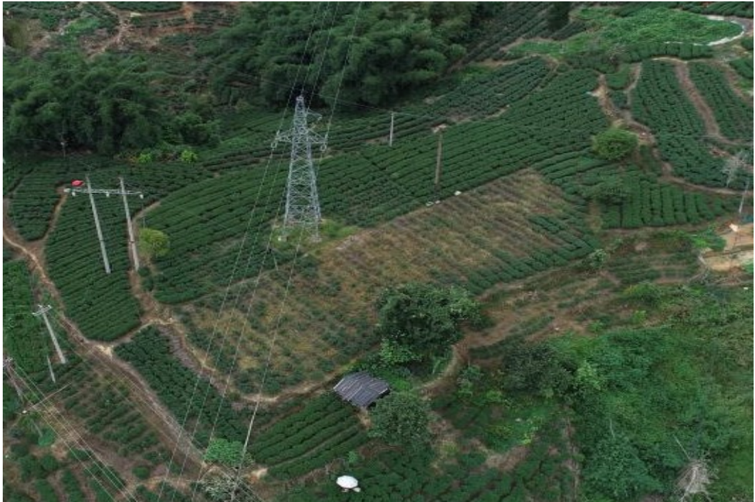
35kV 海乐至那堪变线路沿线现状
