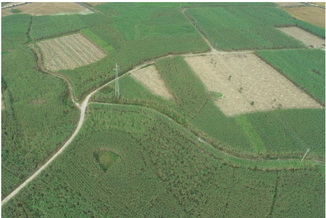
35kV 海乐至那堪变线路沿线现状
