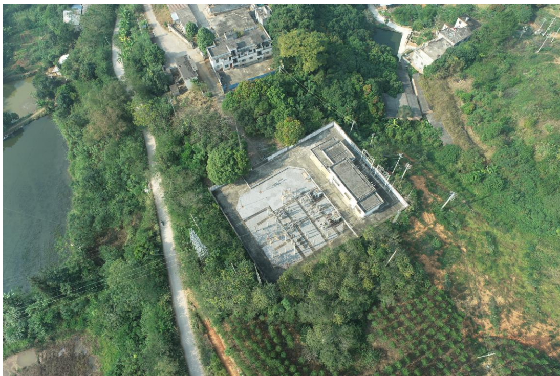
110kV 海乐变电站出线现状
