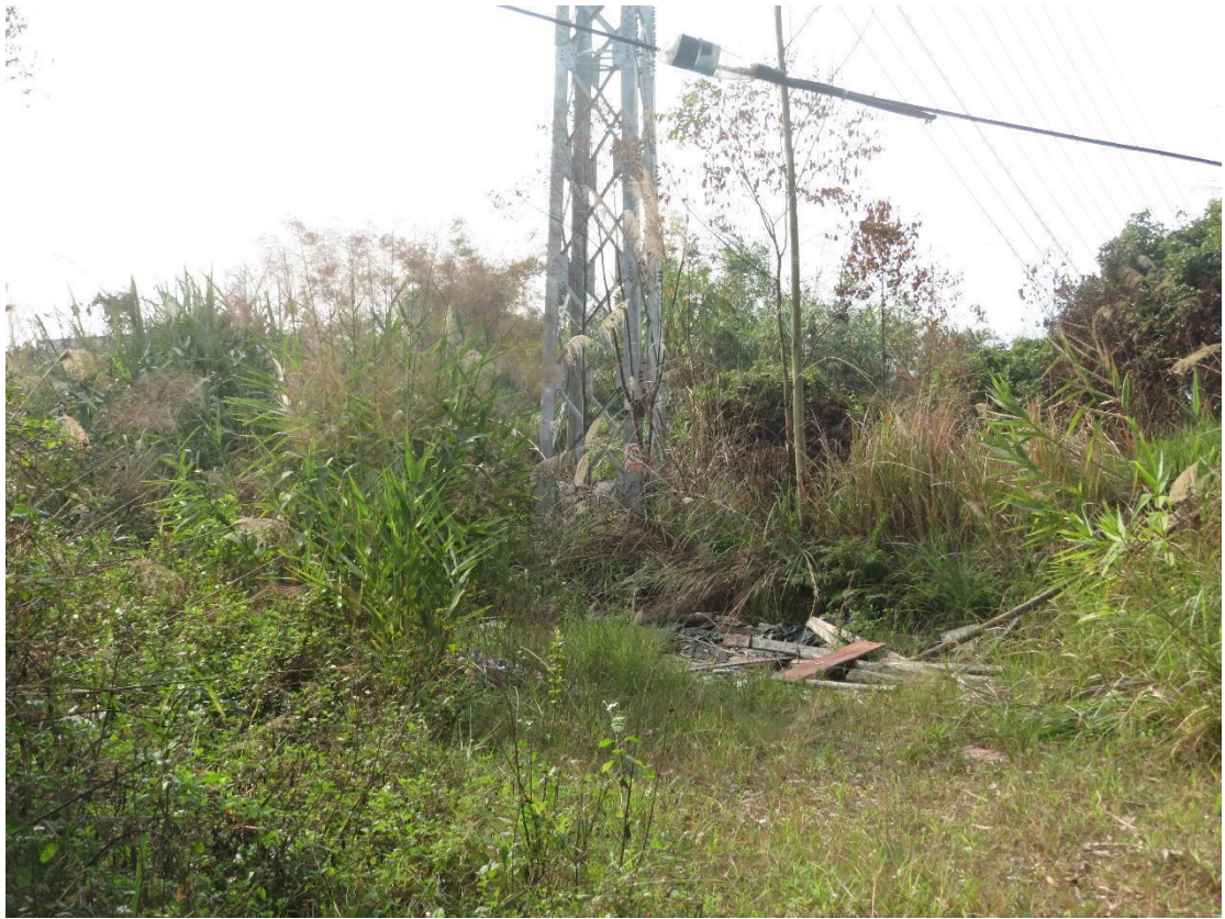
杆基及线路架设区现状照片
