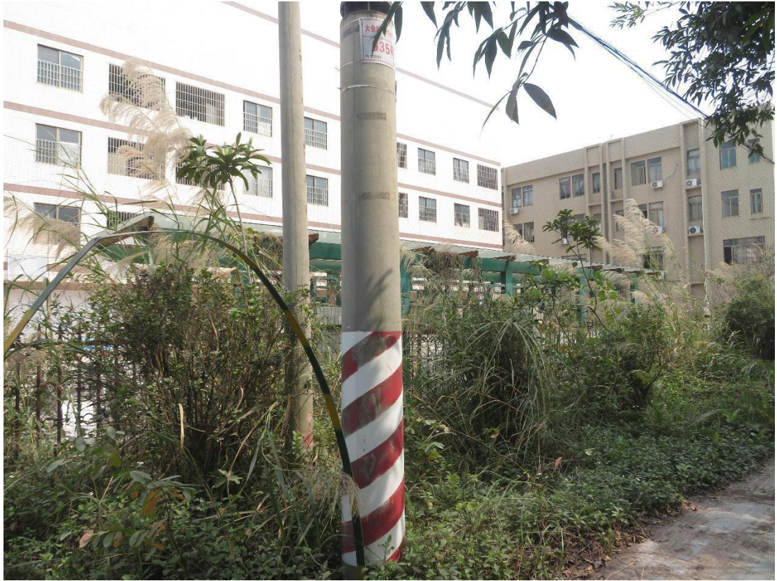
杆基及线路架设区现状照片
