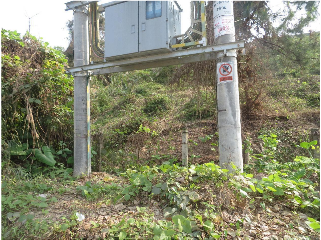
杆基及线路架设区现状照片
