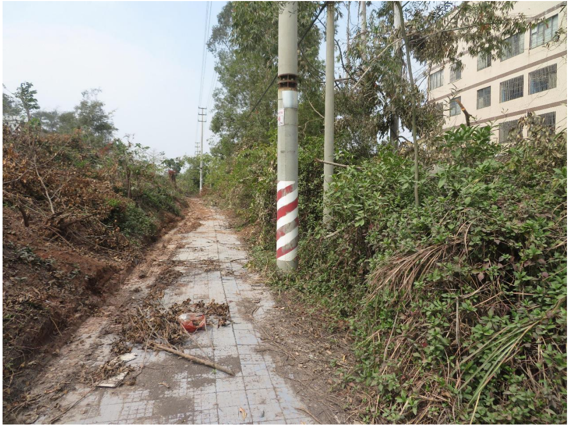
杆基及线路架设区现状照片
