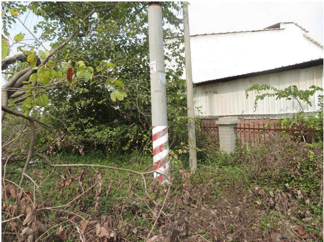
杆基及线路架设区现状照片
