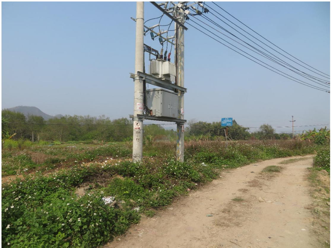
杆基及线路架设区现状照片
