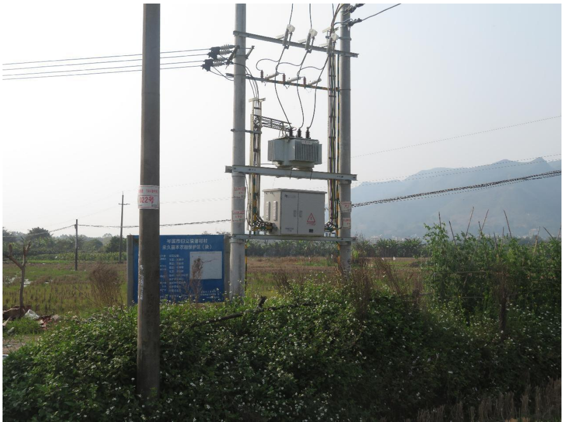
杆基及线路架设区现状照片
