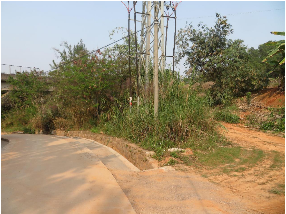
杆基及线路架设区现状照片
