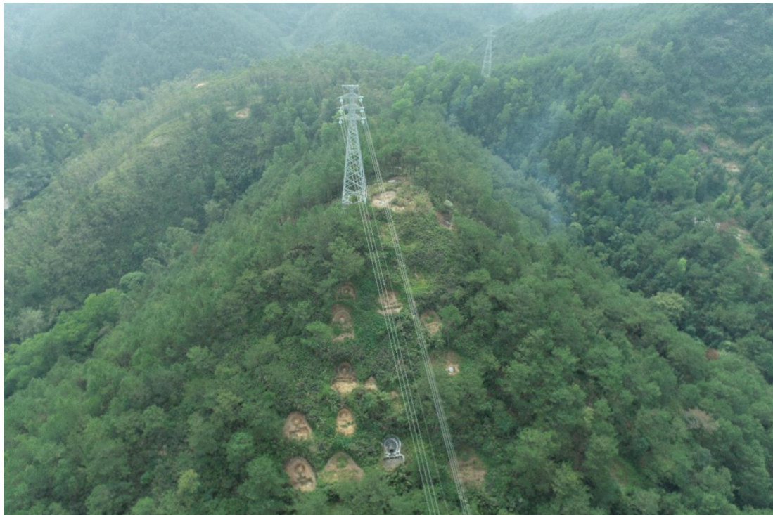
线路建设区照片
