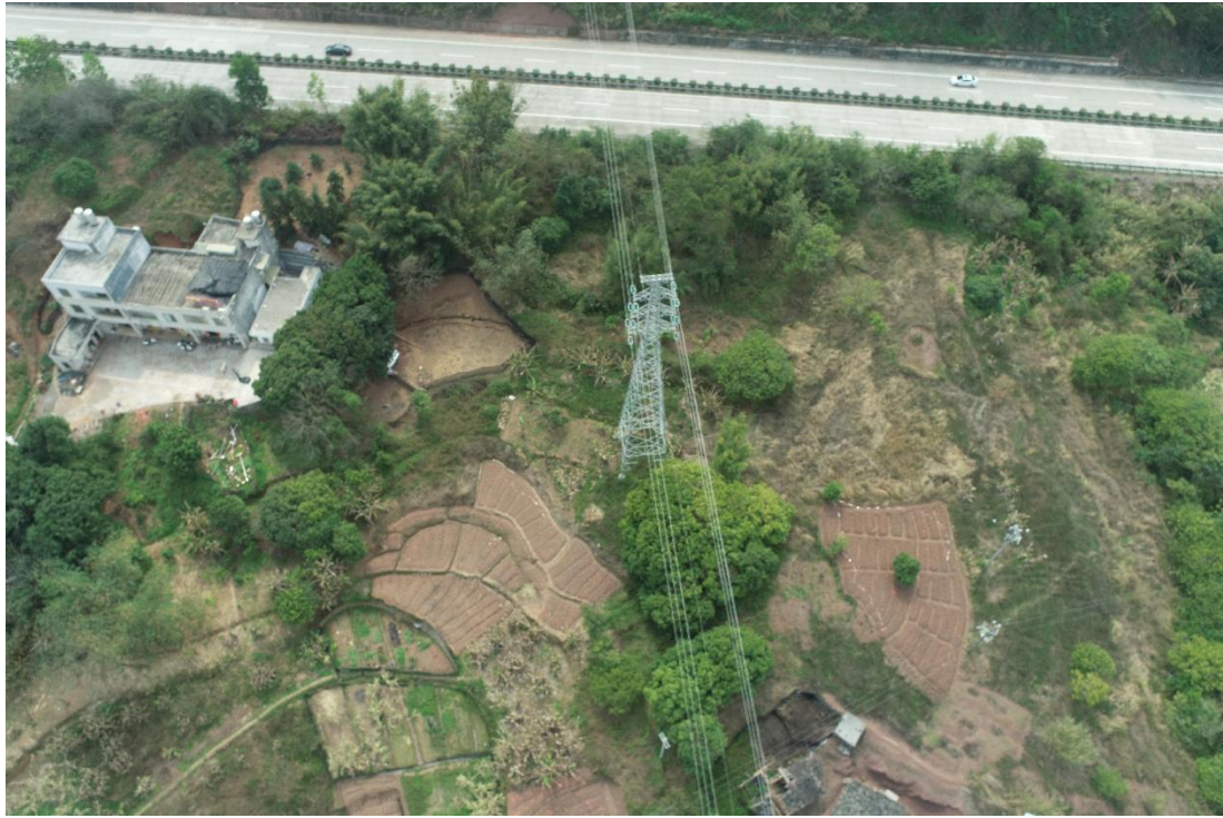
线路建设区照片
