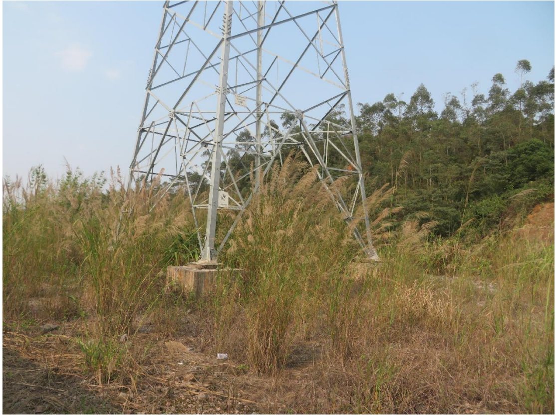
线路建设区照片
