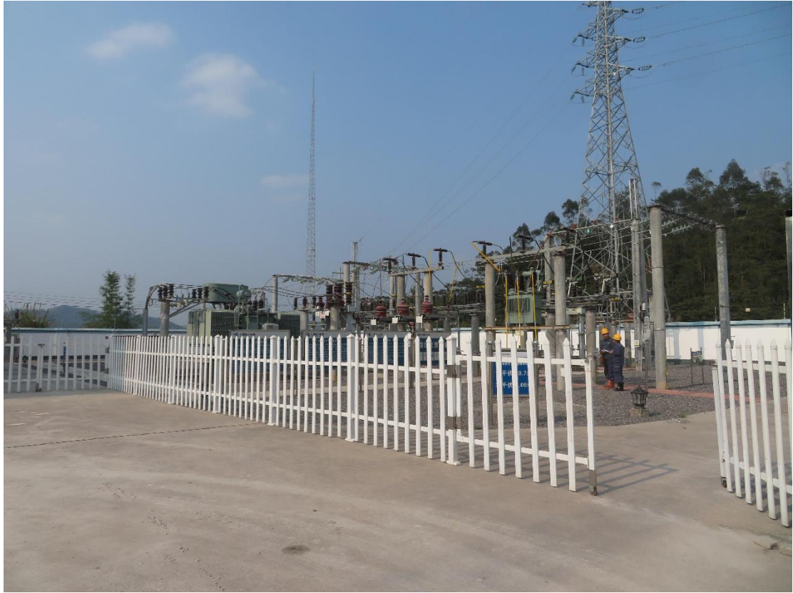
变电站内碎石压盖及场地硬化照片
