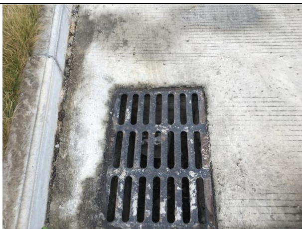
雨水管（雨水口）
