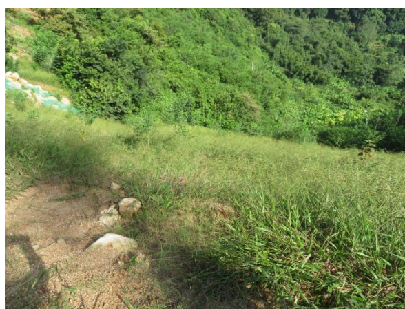
道路填方边坡
