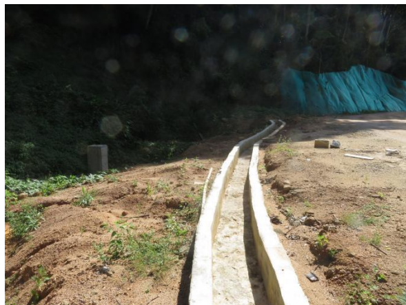
混凝土截排水沟
