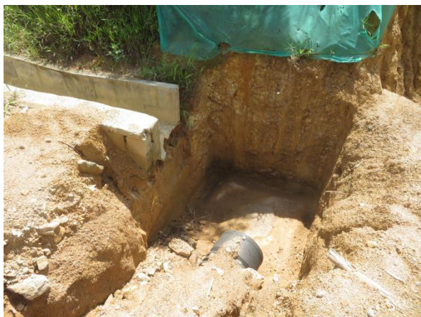
道路沉砂池施工过程（监测点）
