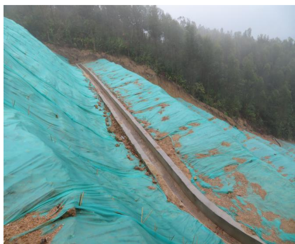
道路边坡平台排水沟
