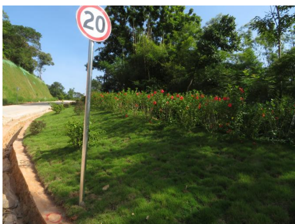
升压站边坡绿化
