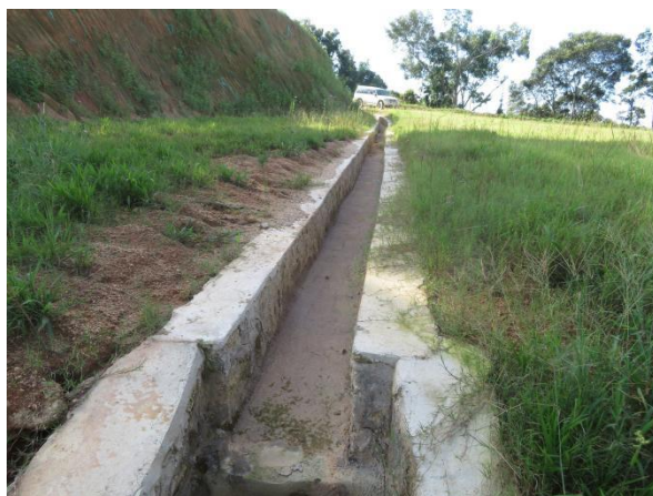
风机截排水设施
