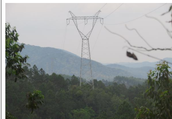
线路走廊植被恢复情况 1
