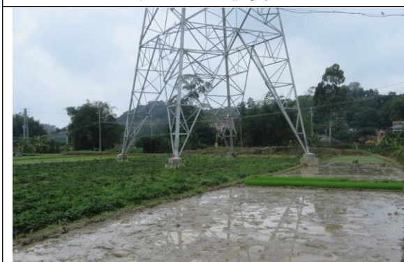
塔基处生态恢复 3
