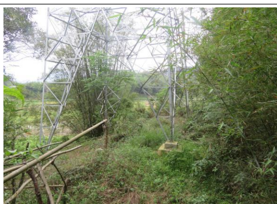
塔基处生态恢复 2
