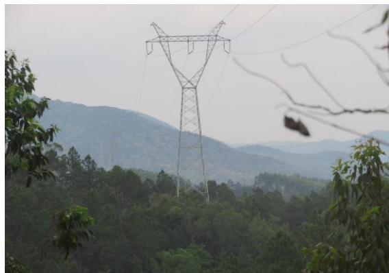
线路走廊植被恢复情况 1
