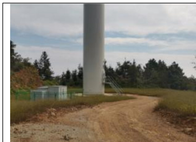
15#风机平台混播草籽绿化
