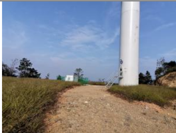
8#风机平台混播草籽绿化
