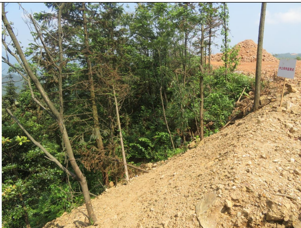
7#监测点（12#风机下边坡）
