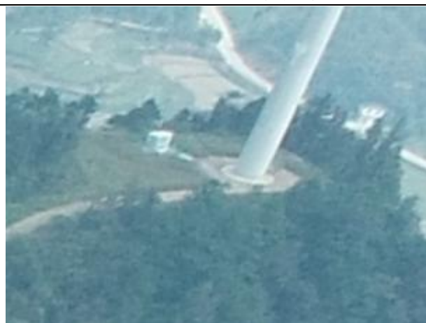
18#风机平台混播草籽绿化
