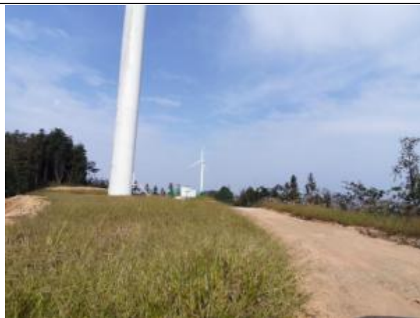
6#风机平台混播草籽绿化
