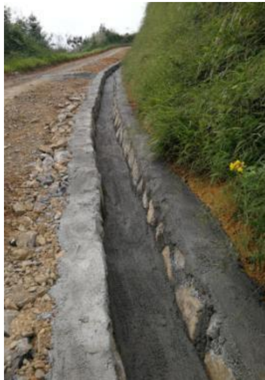
22#风机检修道路内侧已砌浆砌石排水沟
