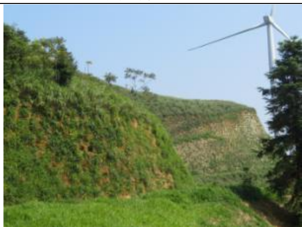
道路上边坡石质边坡打孔穴播（野葛+蔓生莠竹）
