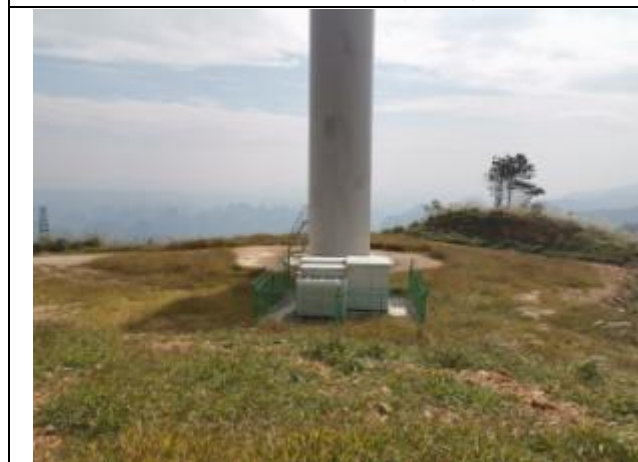
17#风机平台混播草籽绿化
