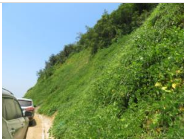
道路上边坡土质边坡条播草籽（野葛+蔓生莠竹）
