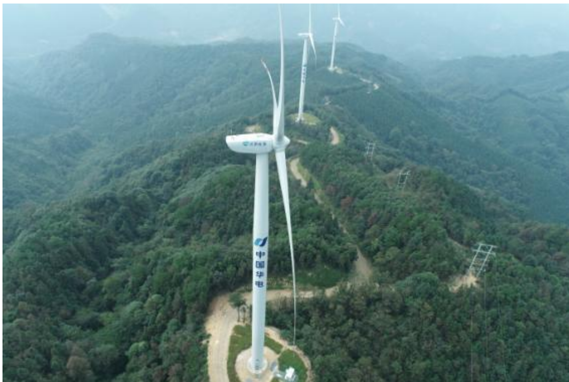
自北向南 1#、2#、3#风机平台及其连接道路、主路植被恢复情况
