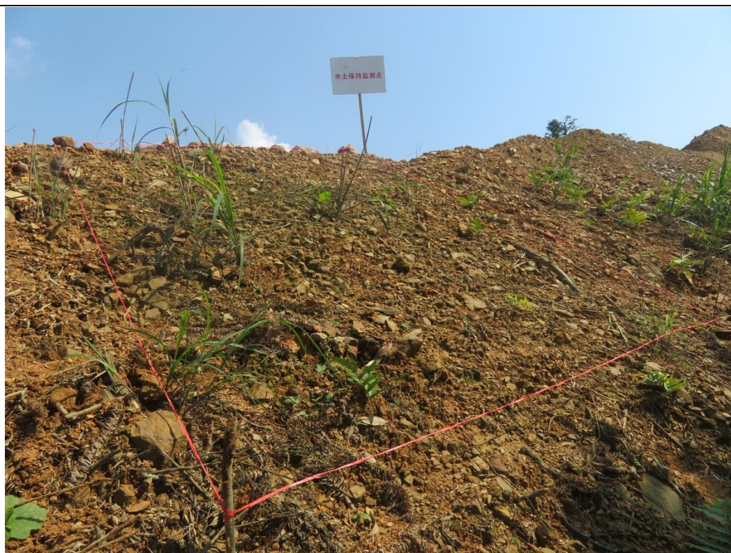
5#监测点（14#风机下边坡）
