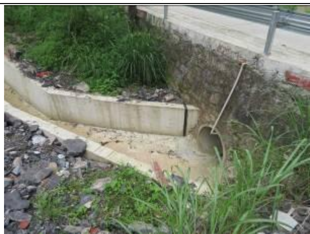
升压站排水沟接进站道路涵管
