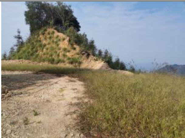
7#风机平台混播草籽绿化
