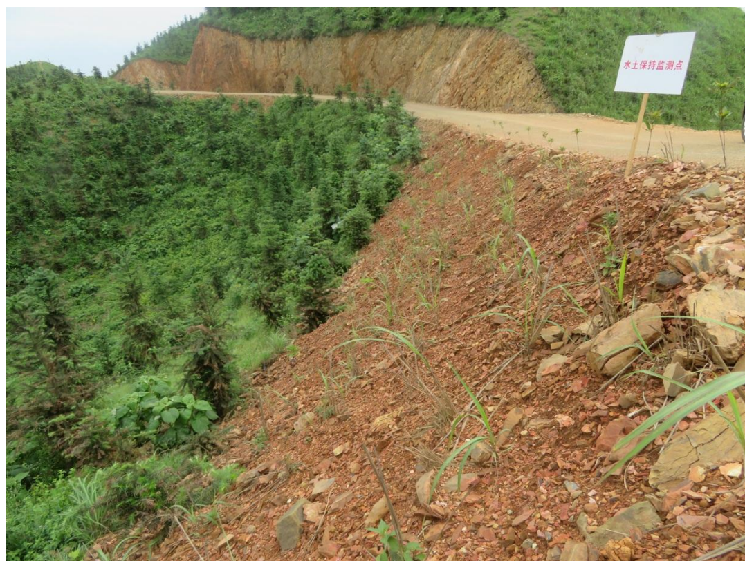
2#监测点（F21#风机北侧场内道路一侧临时堆土场）
