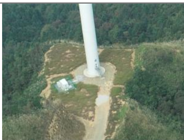
16#风机平台混播草籽绿化
