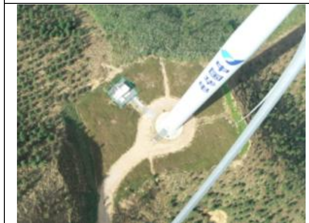
19#风机平台混播草籽绿化
