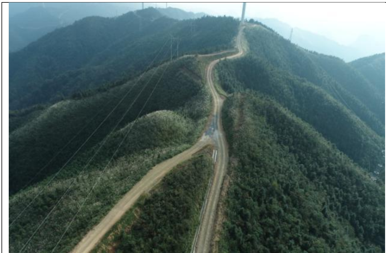
道路边坡绿化效果及浆砌石排水沟
