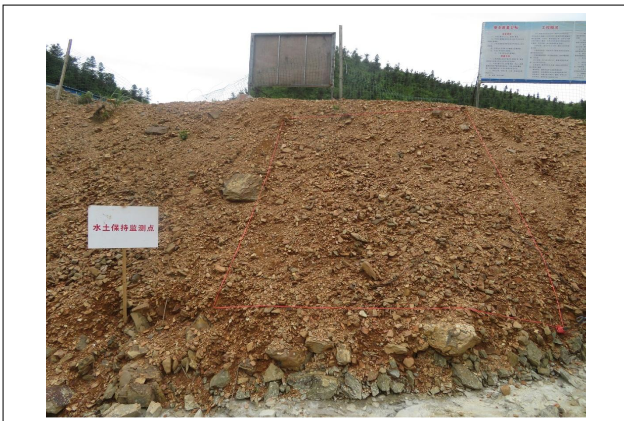
3#监测点（2#弃渣场下边坡）
