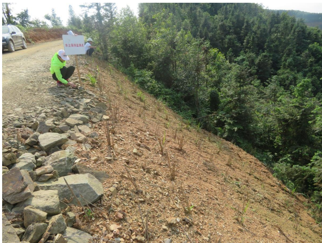
6#监测点（9#风机西北侧道路下边坡）
