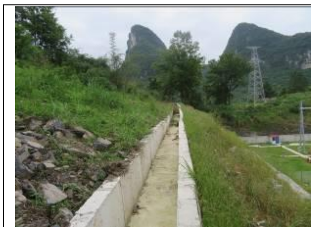
升压站上边坡截水沟
