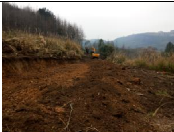
新建场内道路表土剥离
