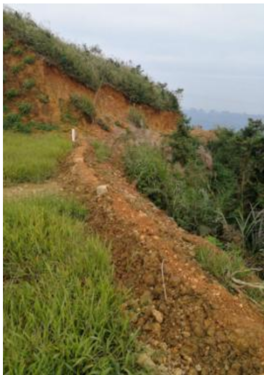
22#风机平台边缘设土坎拦挡
