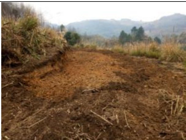
新建场内道路表土剥离
