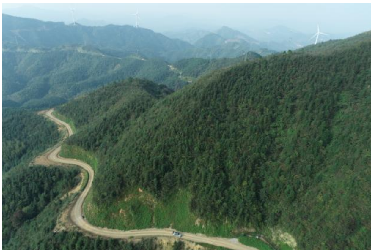
道路边坡绿化效果及浆砌石排水沟
