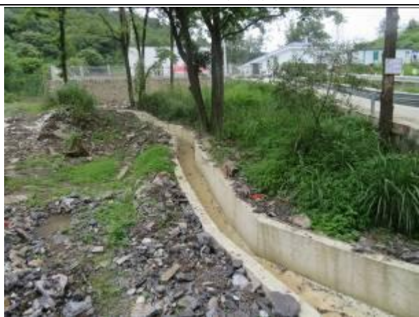
升压站排水沟
