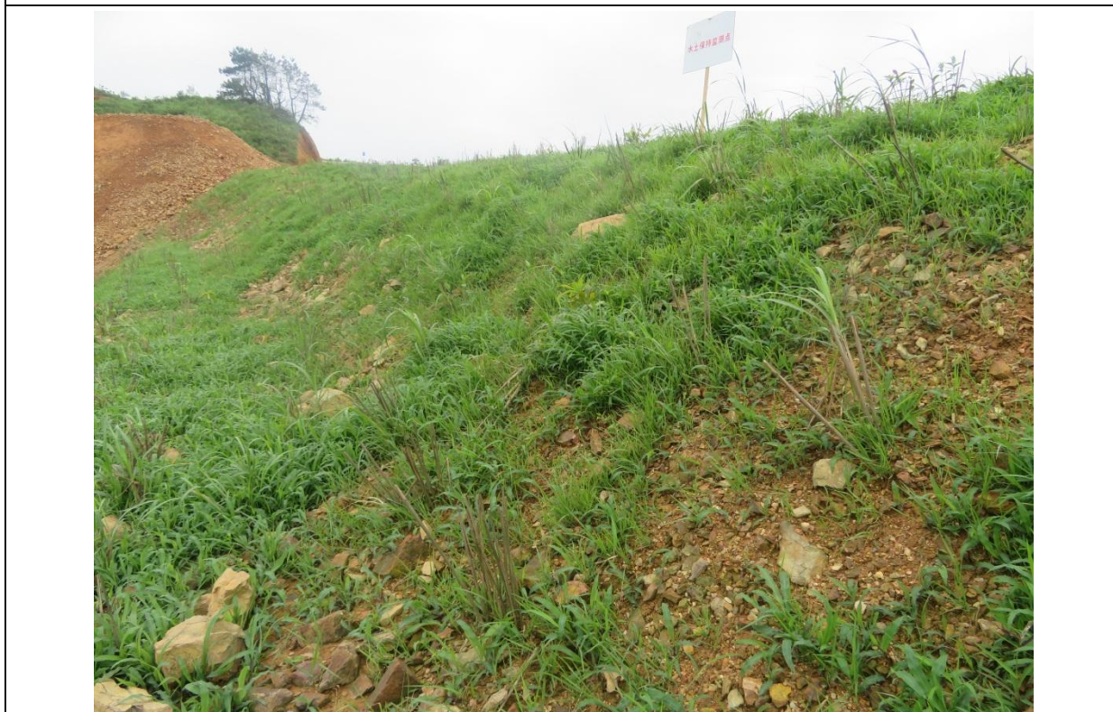
4#监测点（3#弃渣场下边坡）
