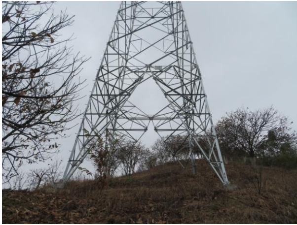
110kV 望麻线 19#塔基植被恢复情况
