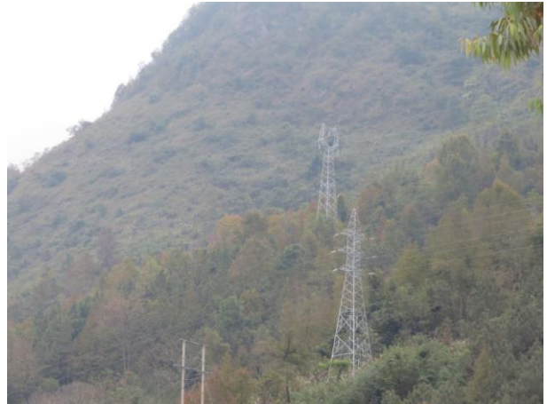
110kV 望麻线沿线塔基植被恢复情况
