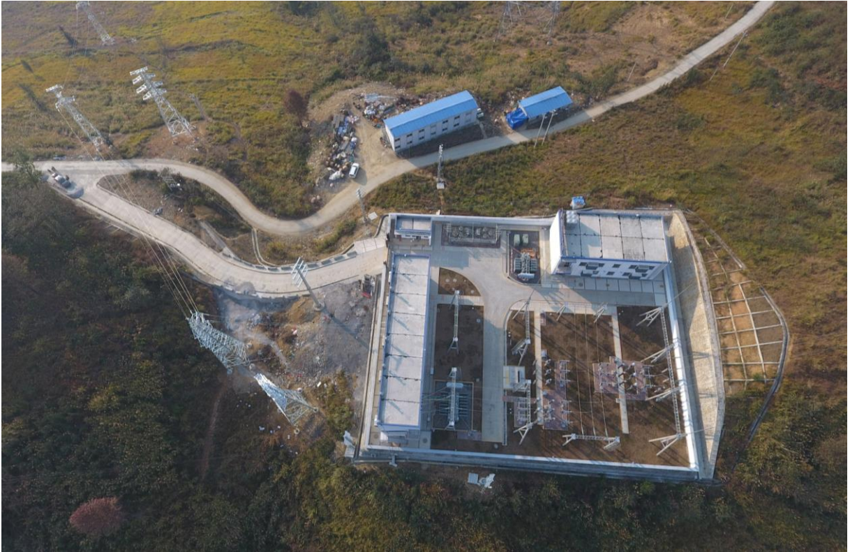
110kV 纳夜变电站措施体系：站内绿化、站外综合护坡、截水沟、排水沟，进站道路两侧排水沟
