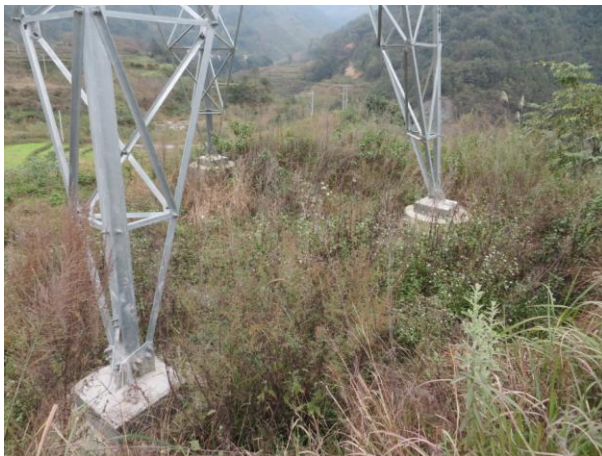
110kV 望麻线沿线塔基植被恢复情况
