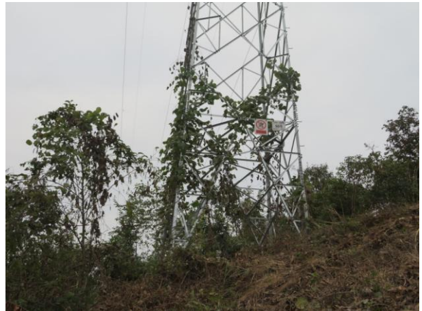
110kV 望麻线 50#塔基植被恢复情况
