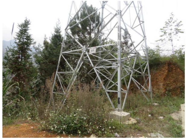
110kV 望麻线 82#塔基植被恢复情况
