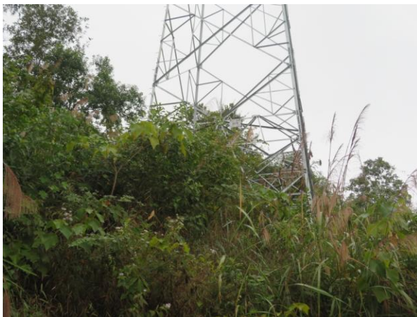
110kV 望麻线 31#塔基植被恢复情况
