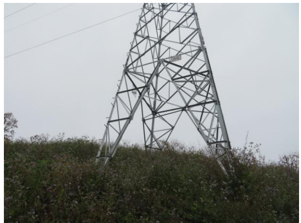
110kV 望麻线 30#塔基植被恢复情况
