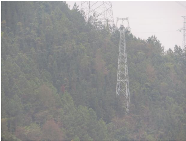
110kV 望麻线沿线塔基植被恢复情况
