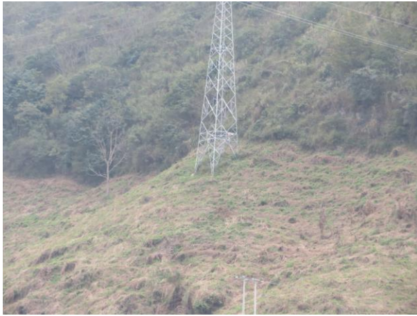
110kV 望麻线沿线塔基植被恢复情况
