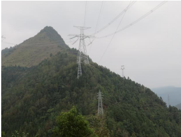
110kV 望麻线沿线塔基植被恢复情况
