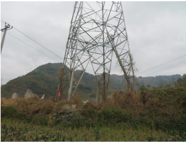
110kV 望麻线 63#塔基植被恢复情况
