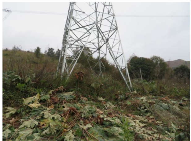
110kV 望麻线沿线塔基植被恢复情况
