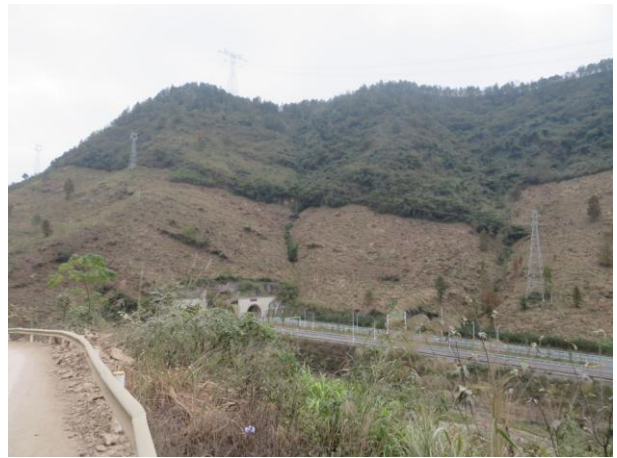
110kV 望麻线沿线塔基植被恢复情况
