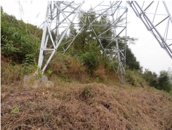
110kV 望麻线 49#塔基植被恢复情况
