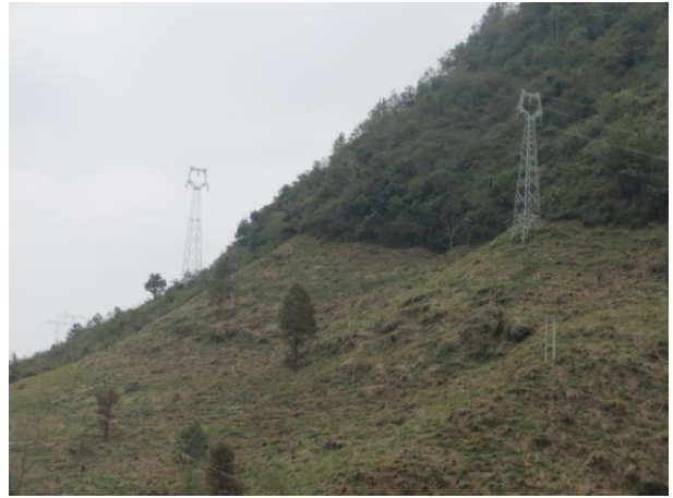
110kV 望麻线沿线塔基植被恢复情况
