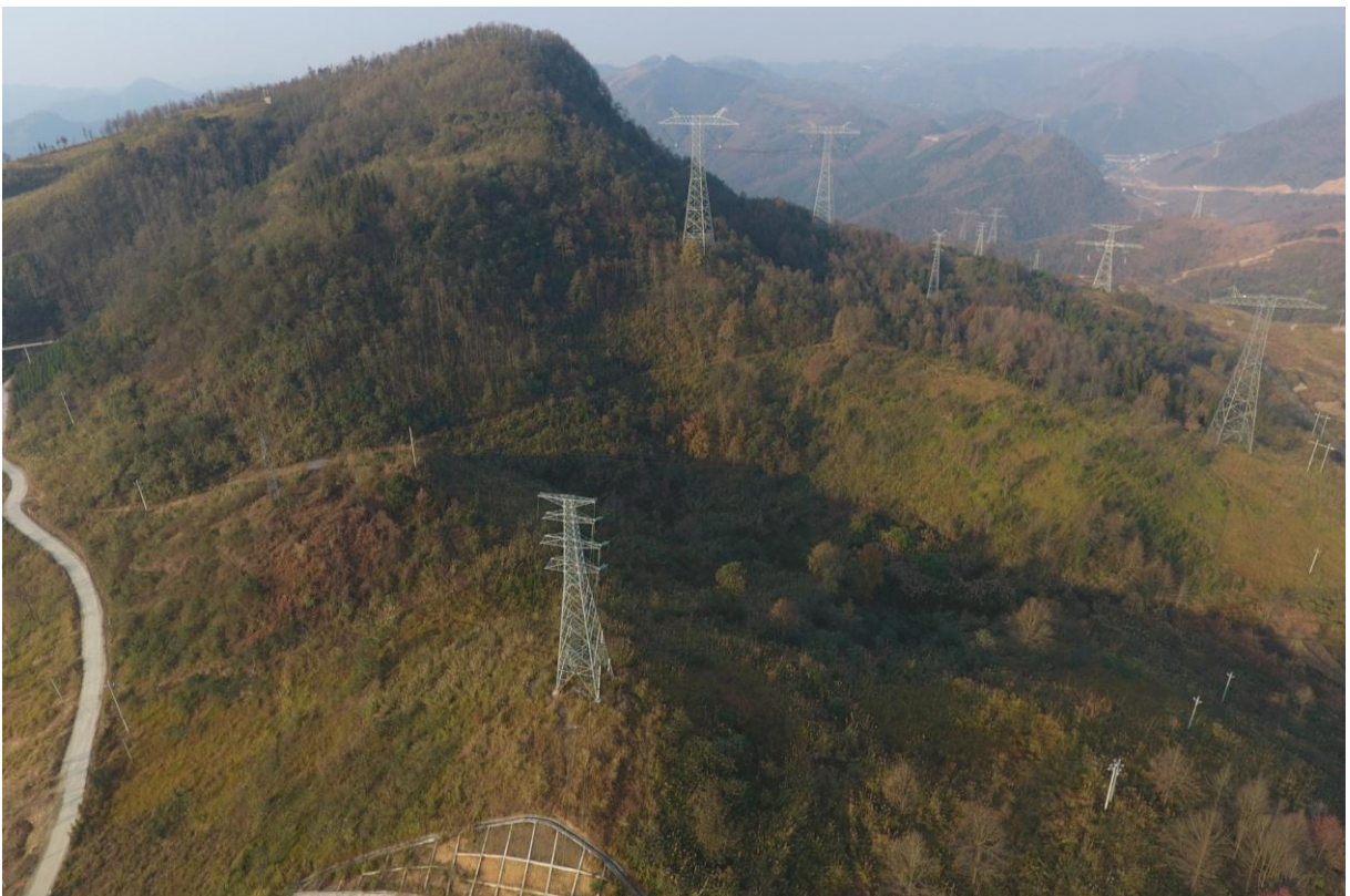
110kV 纳夜变电站出线段、110kV 望麻线沿线塔基植被恢复情况
