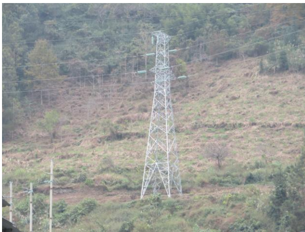
110kV 望麻线沿线塔基植被恢复情况
