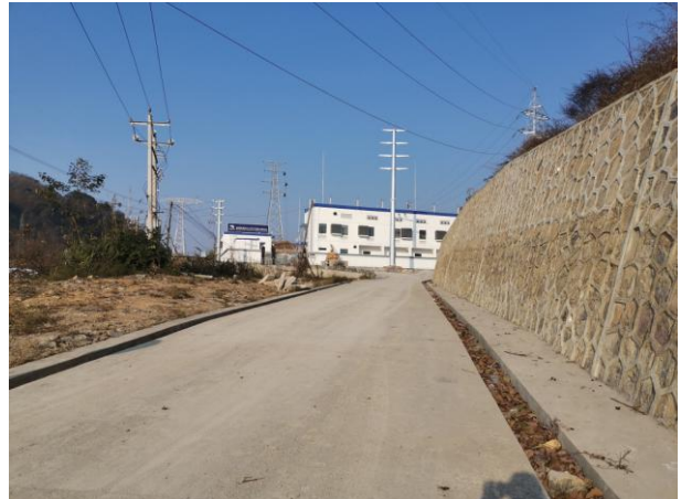
进站道路排水沟
