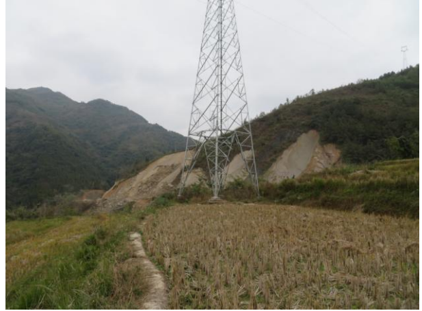
110kV 望麻线沿线塔基植被恢复情况
