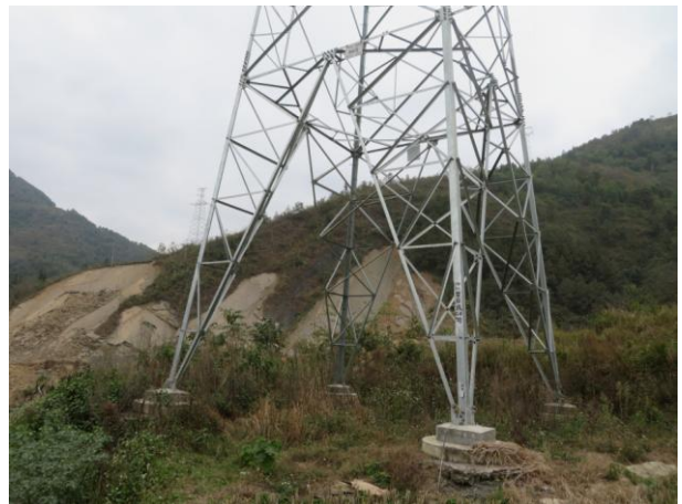
110kV 望麻线 64#塔基植被恢复情况
