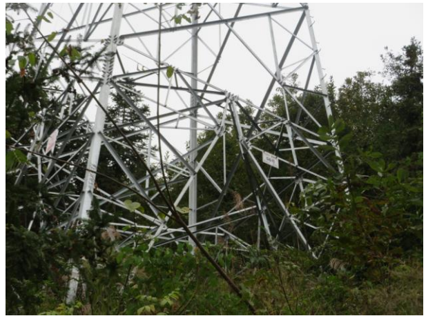
110kV 望麻线 56#塔基植被恢复情况
