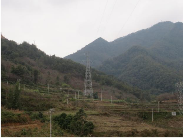
110kV 望麻线沿线塔基植被恢复情况
