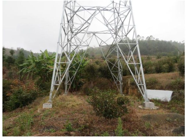
110kV 望麻线 32#塔基植被恢复情况
