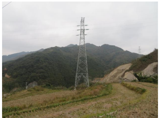
110kV 望麻线沿线塔基植被恢复情况
