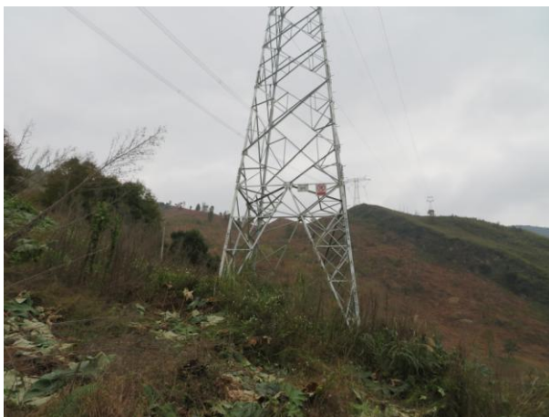
110kV 望麻线 89#塔基植被恢复情况
