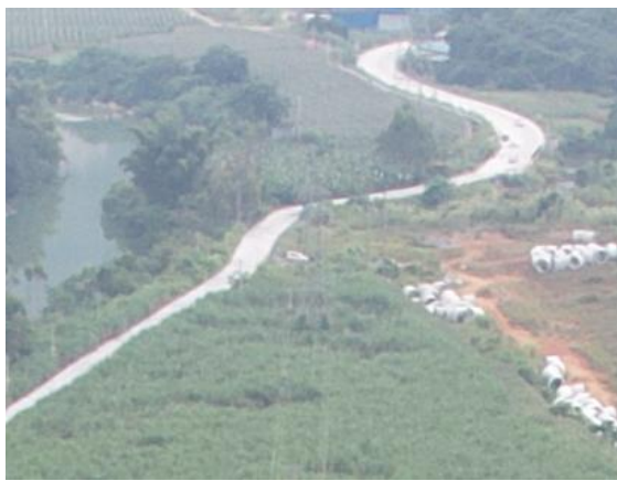
35kV 北雷线 12 号
