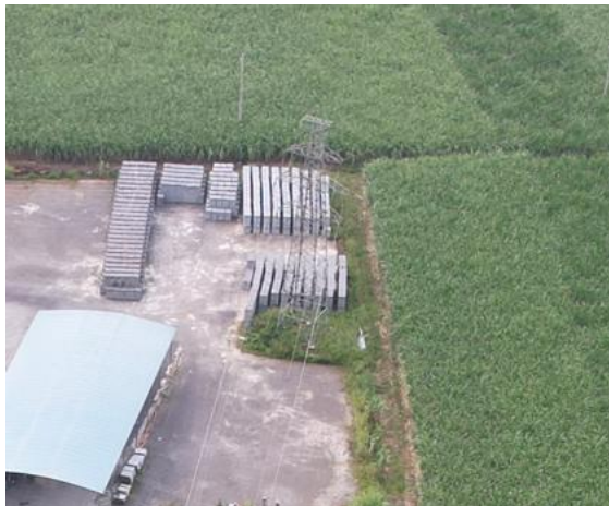
35kV 北雷线 14 号
