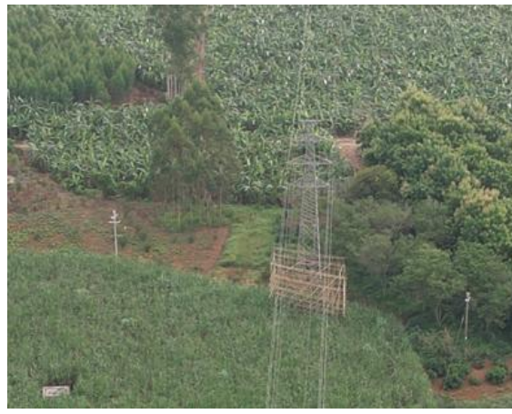
35kV 北雷线 11 号
