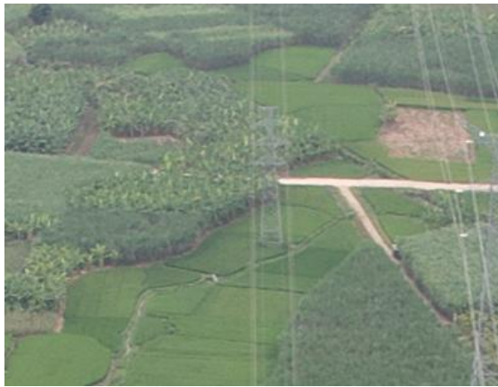
35kV 北雷线 54 号
