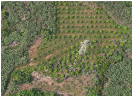
35kV 北雷线 89 号
