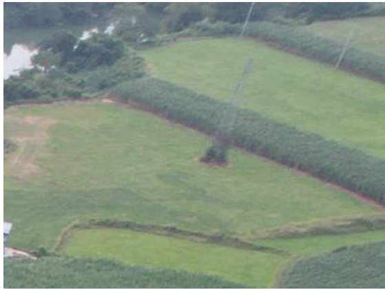
35kV 北雷线 16 号
