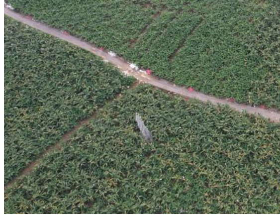
35kV 北雷线 17 号
