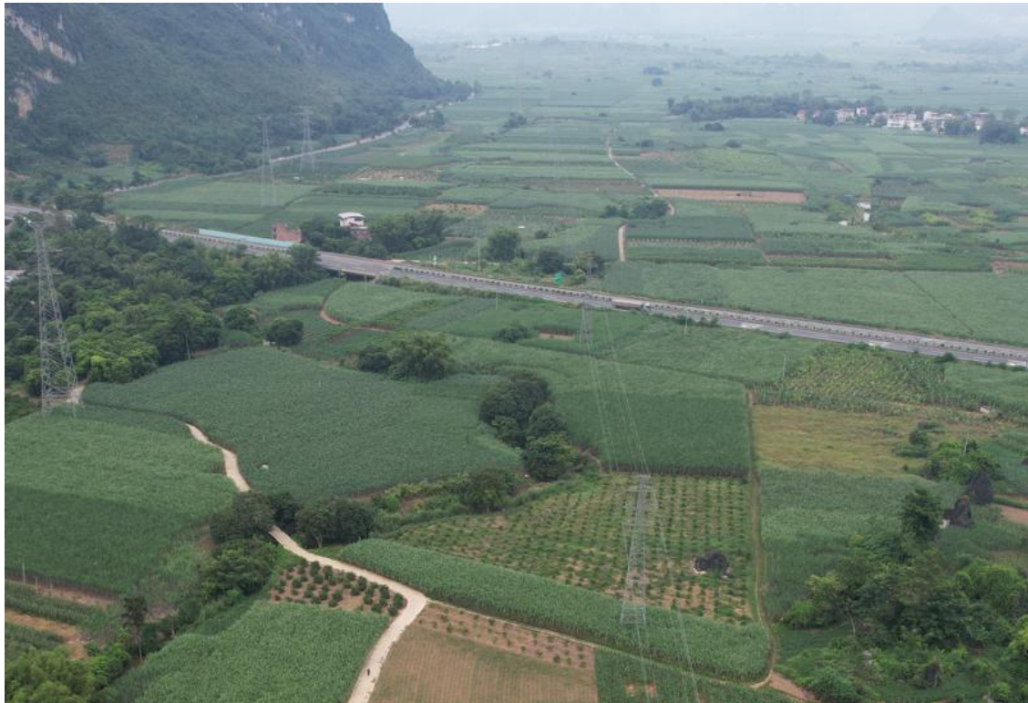
陆榜村收费站~古亮段（右侧小塔）（35kV 北雷线 60~70 号）
