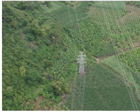
35kV 北雷线 57 号
