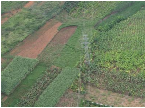
35kV 北雷线 58 号
