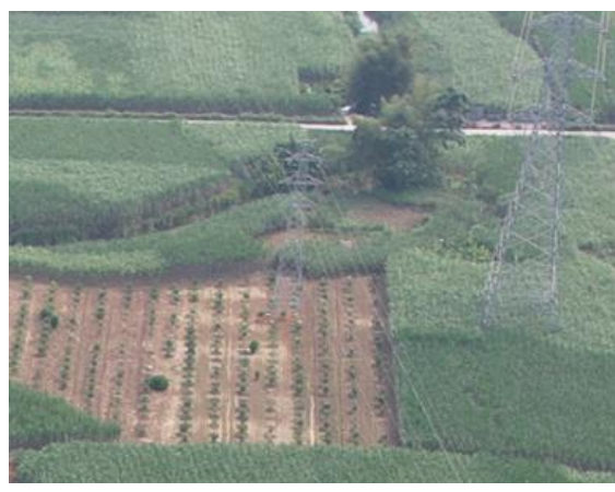
35kV 北雷线 82 号 (小塔)
