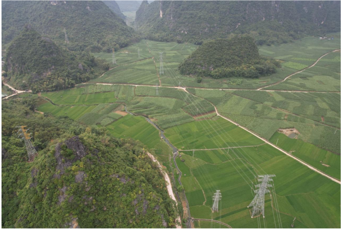
35kV 北雷线（维新村~陇贺段）
