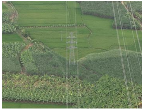
35kV 北雷线 55 号
