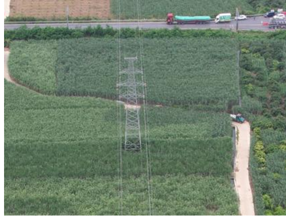
35kV 北雷线 78 号
