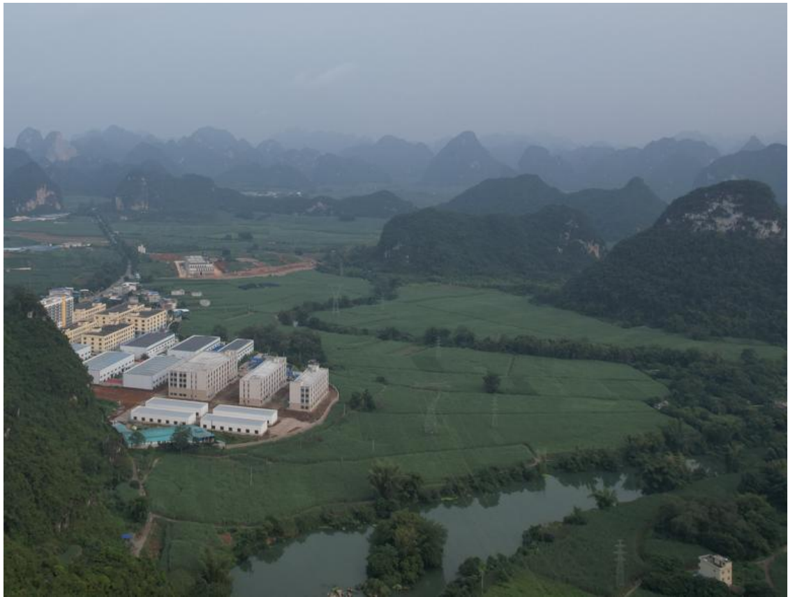
35kV 北雷线（上兴~弄房段）
