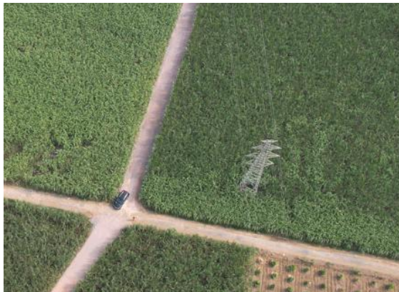
35kV 北雷线 87 号
