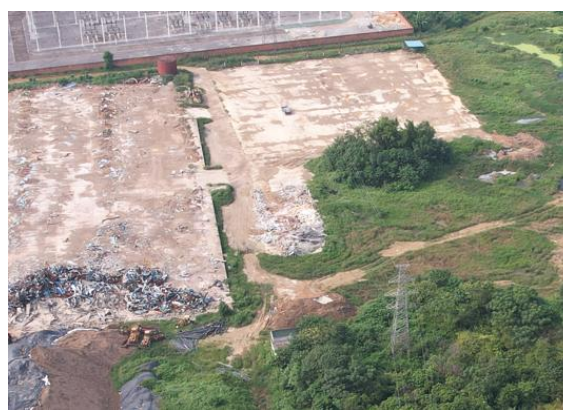
35kV 北雷线 90 号
