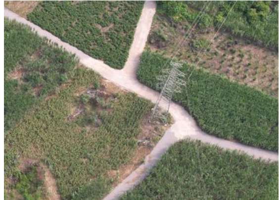
35kV 北雷线 86 号
