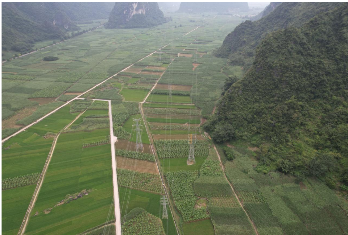
35kV 北雷线（维新村~陆榜村段）
