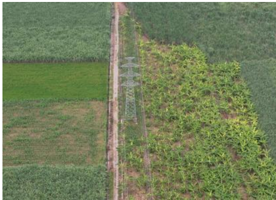
35kV 北雷线 79 号
