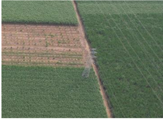
35kV 北雷线 83 号
