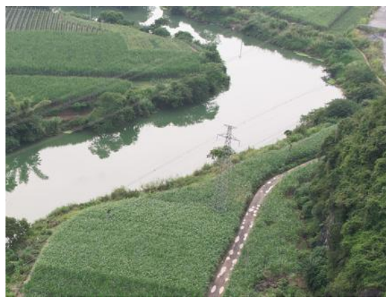
35kV 北雷线 13 号
