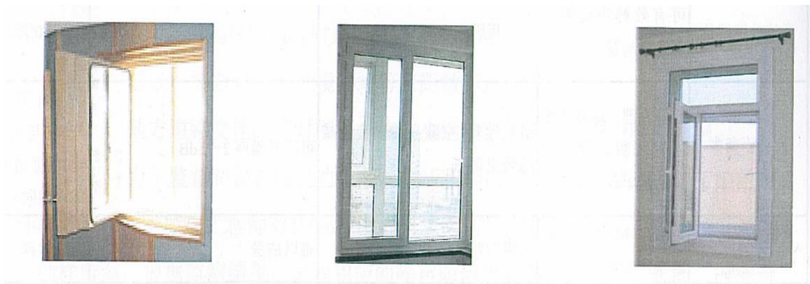
图 5.5-2 典型通风式隔声窗示意图
