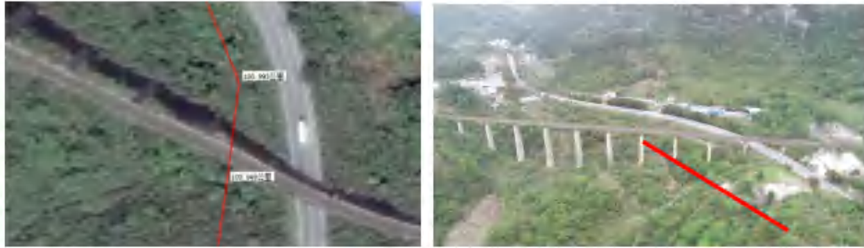
图 2.6-2 管道穿越铁路情况
