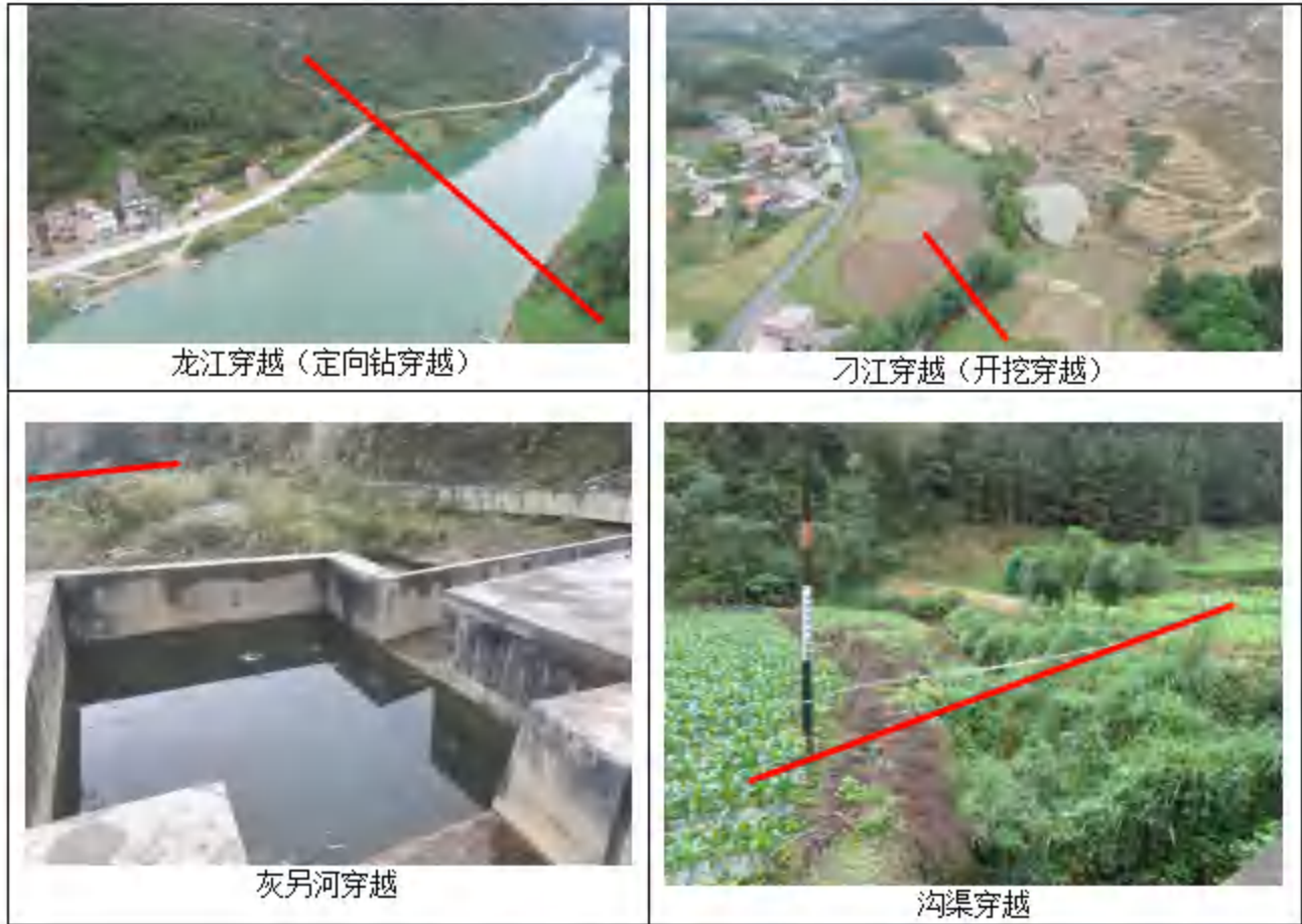
图 2.6-1 管道穿越河流、沟渠情况
