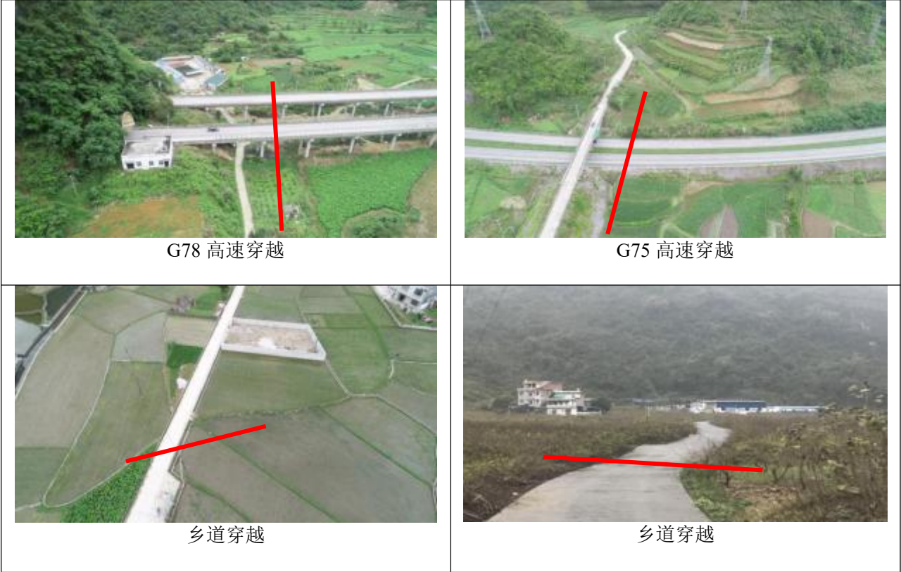
图 3.6-2 管道穿越部分公路情况
