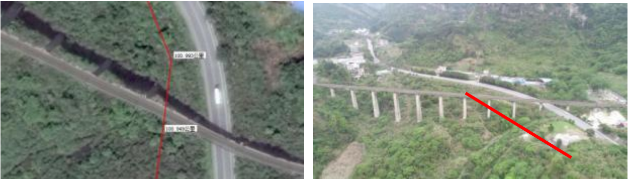
图 3.6-2 管道穿越铁路情况
