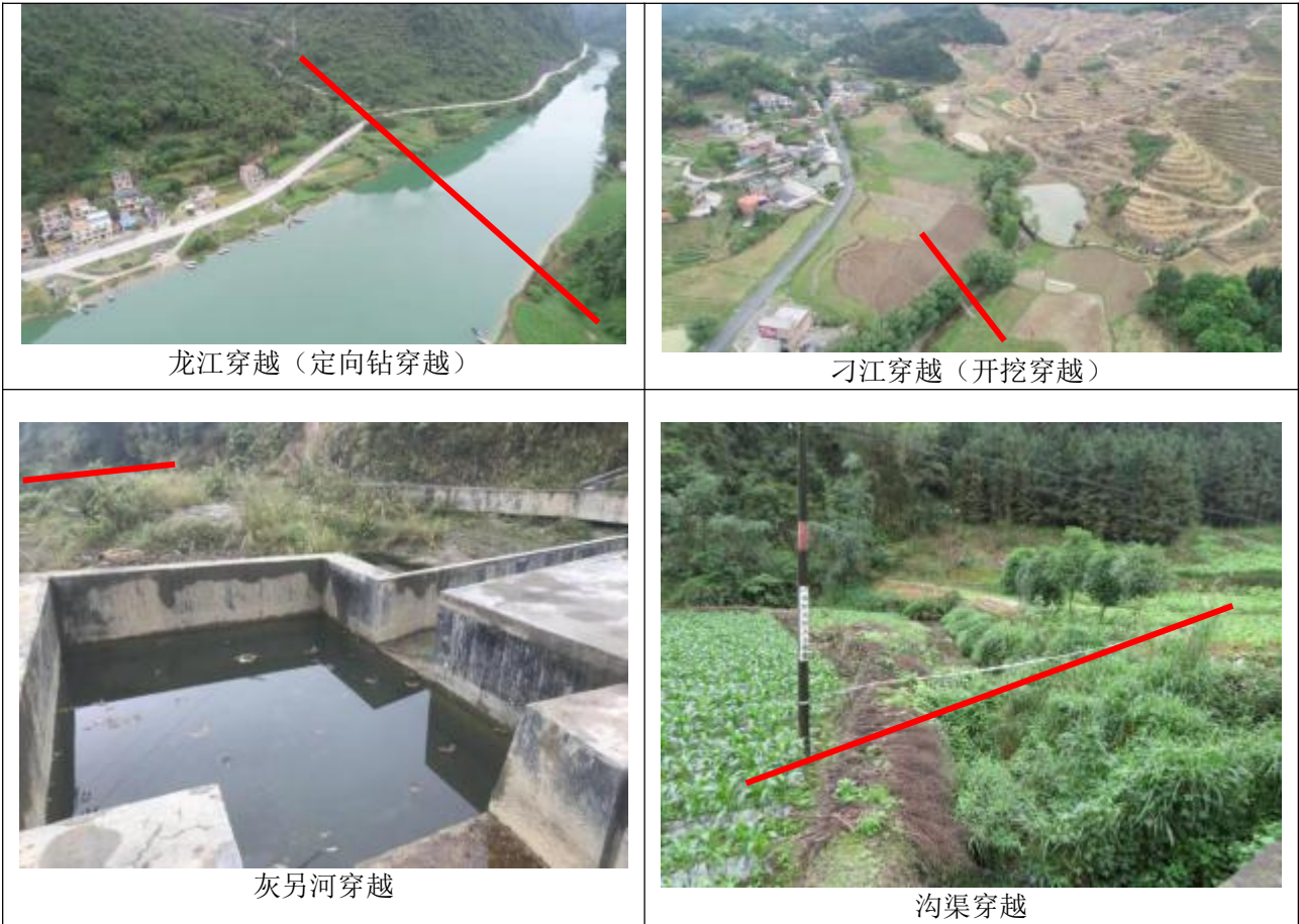
图 3.6-1 管道穿越河流、沟渠情况
